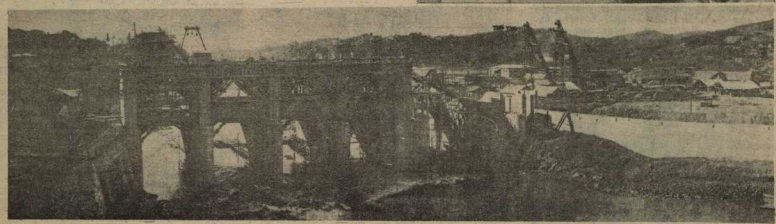
панорама строительства районной гидро-электрической станции
