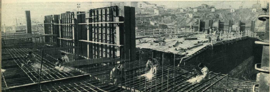
На нижнем судоходном шлюзе Куйбышевской ГЭС ведется монтаж арматуры.
