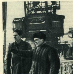
Комсомольско-молдавская бригада бетонщиков В. Фотина — одна из лучших на строительстве водосливной плотины Камского гидроузла. Она выполнит задание на 150—200 процентов. И с ним и к с: бригадир В. Фотин (слева) и старший мастер В. Шалаев.
