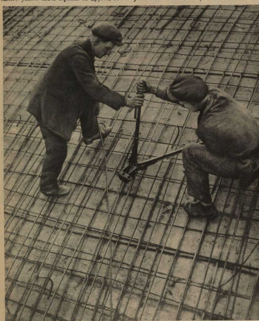
Путистрой. На стройке мазельбетонной крыши
