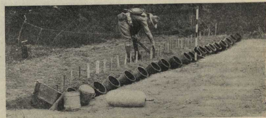
Батарея газометра Лигенса: все газометры батареи стреляют одновременно по замкнутому электрическому току; таким образом достигается чрезвычайная высокая концентрация газа на обстреливаемом участке. Каждая газовая бомба (одна из них видна на первом плане) содержит 15 килограммов стреляющего вещества.
