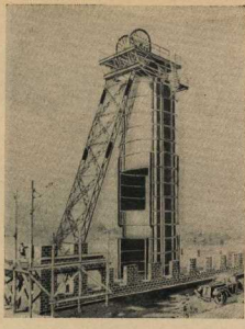
Эскизный проект копра. Такой копр будет установлен на шахте, где работает Николай Лукичёв.
