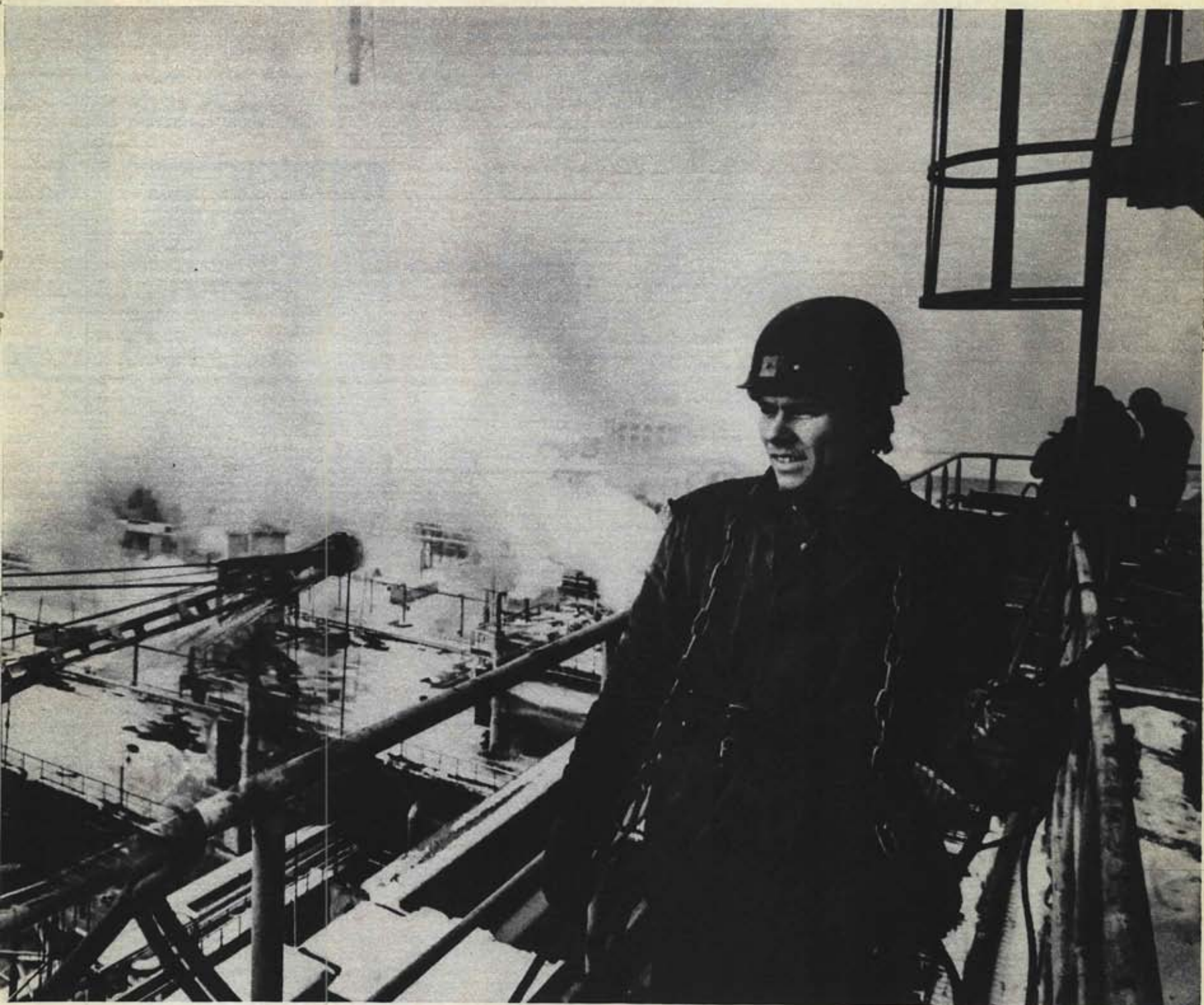
ХИМИЧЕСКИЙ ГИГАНТ НА СЕВЕРНОМ КАВКАЗЕ ПОСТОЯННО РАСТЕТ. ИДЕТ СТРОИТЕЛЬСТВО ШЕСТОЙ ОЧЕРЕДИ
