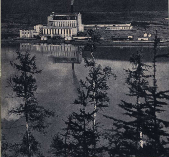
Жемчужина Колымы — так называют Арзангальскую ГРЭС. Эта электростанция снабжает энергией близлежащие шахты и прииски, поселки угольщиков, драгм...
