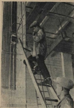
ЭЛЕКТРОЗАВОД ГЭТ. Ударники на бригады элетромонтеров за сборованием нового цеха.
