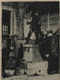
Установка новых машин на Надеждинском заводе на Урале.
