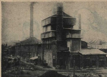
НА «КРАСНОМ ВЫБОРЖЦЕ». Электрический пылеуловитель, улавливающий ценную окись цинка из газов, отходящих от печей.
