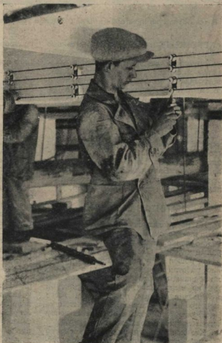
ЭЛЕКТРОЗАВОД ГЭТ. Электромонтер из группы ударников.
