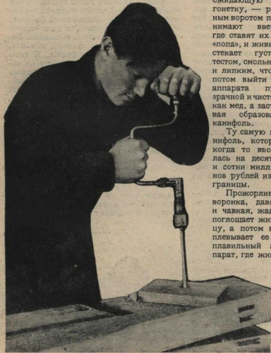
Сверление вручную.
