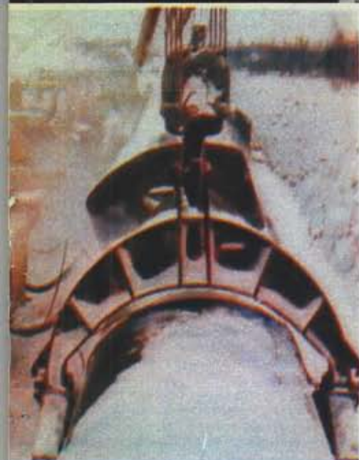
УКЛАДКА «НИТИ» В ТРАНШЕЮ — ОДНА ИЗ ОТВЕТСТВЕННЕЙШИХ ОПЕРАЦИЙ.
