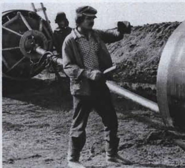
ПЕРЕД СВАРКОЙ ПЛЕТИ ЦЕНТРУЮТ.
