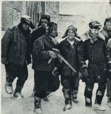
Смена окончена. Строительную площадку ТЭЦ покидают молодые одноклассники-верхолазы во главе со своим бригадиром Николаем Муттом.
