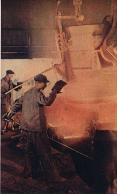
Мартеновский цех. Стопор открыт, сталь хлынула в изложницу...
