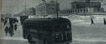
Главная улица после строительства.
