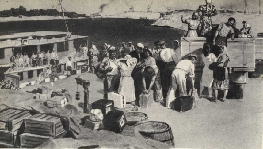
Прибыли на стройку.
