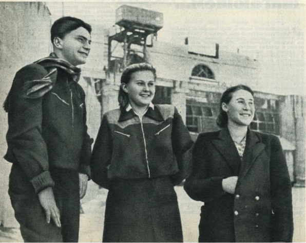
Комсомольцы-строители Карповской насосной станции (слева направо) Владимир Дудник, Ирина Субач и Ида Сиянко, секретарь комсомольского бюро участка.
