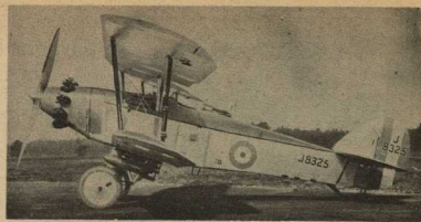
Английский дневной бомбардировщик «Хаттер» с мощным мотором в 280 л. с., скорость 270 км. в час
