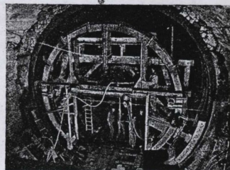
Работы по сооружению подводного туннеля.
