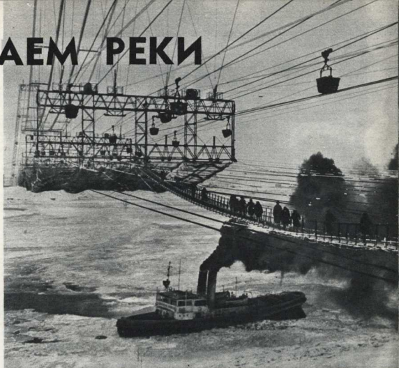
Строительство Сталинградской ГЭС. Паденная канатная дорога.
