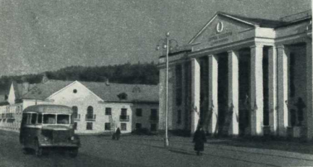
Неподалеку от Куйбышевской ГЭС вырос новый город гидростроителей — Жигулевск. На снимке: одна из улиц юного города.
