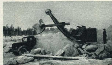
Все трудоемкие работы на стройке механизированы. На снимке: погрузка гравия на самосвал.
