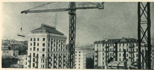
На Крещатике идет стройка.
