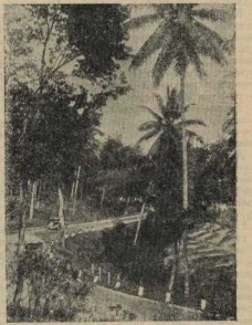
Шоссеяная дорога в Сингапуре.
