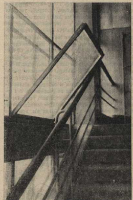
8. Форточка для протирания громадного окна сделана так, что при всем желании протереть окно невозможно
