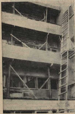
3. Балконы в новом доме, подберижаемые деревянными подпорами
