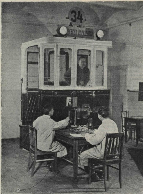
Испытательная трамвайная площадка в Психотехнической лаборатории МНХ
