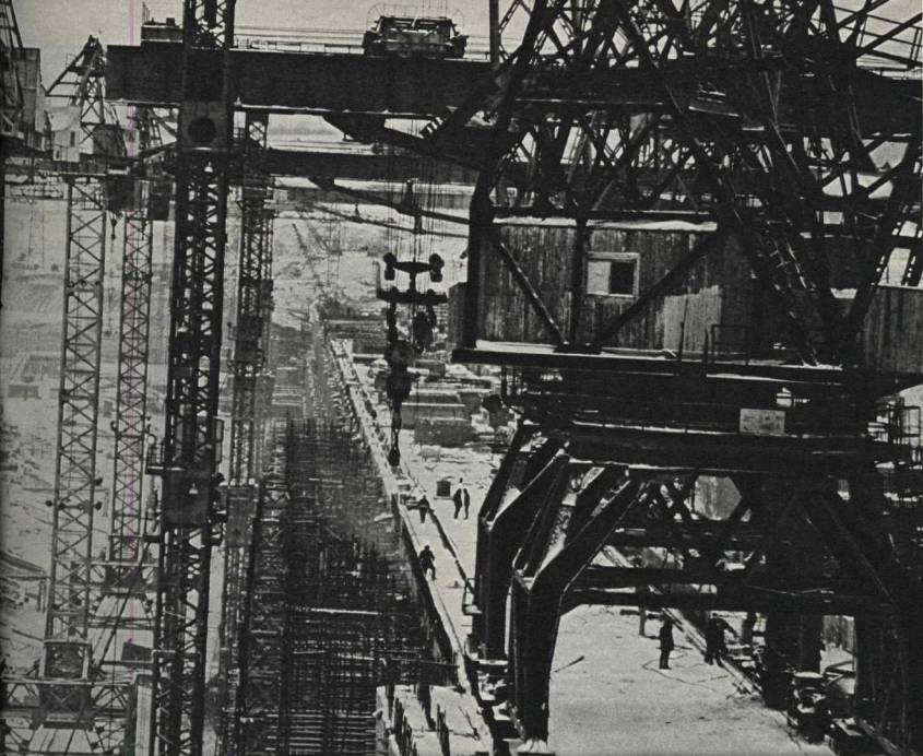
Турбинный зал и плотина освещены в едином здании строящейся в Балакове гидроэлектростанции.
