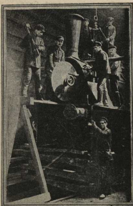
„КРАСНЫЙ ПУТИЛОВЕЦ“. Комсомольцы на ремонте паровоза.
