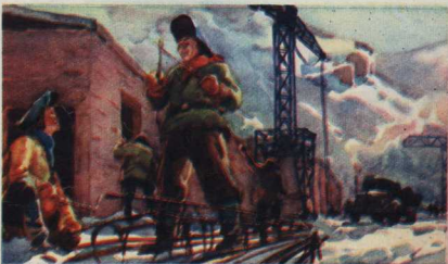
НАПРЯЖЕННЫЙ ТРУД КИПИТ НА ВСЕХ УЧАСТКАХ СТРОИТЕЛЬСТВА КРАСНОЯРСКОЙ ГЭС.
