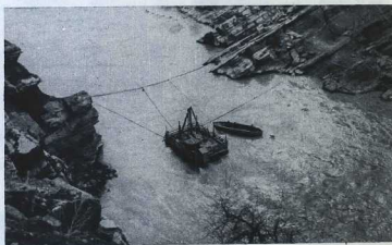
Посреди бурного Вахша высится буровая установка геологов, изучающих дни реки. Пройдет время, и этот снимок станет частью исторической — на этом месте плотина перегородит неслыханное ущелье.
