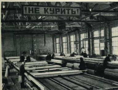
В домостроительном цехе на конвейере собираются щиты стены будущего дома.
