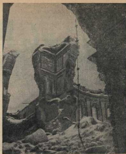
Здесь стояло великолепное здание монастыря «Новый Иерусалим». Жители города Истры по праву гордились этим прекрасным памятником русского зодчества. Фашистские варвары превратили его в руины...
