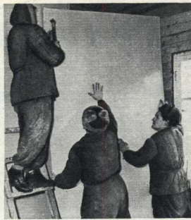
Чем хороши метод сухой шпунтурной? Один лист — на полстены.
