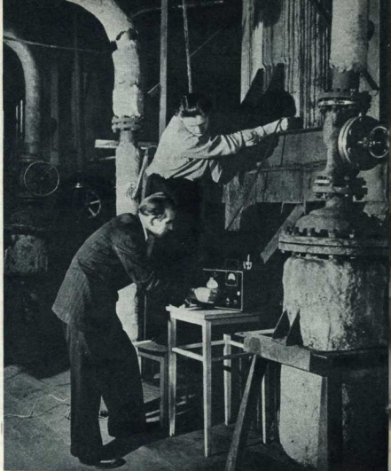
Определение толщины металлической стенки атомлава на гидростанции завода при помощи ультразвукового толщиномера.
