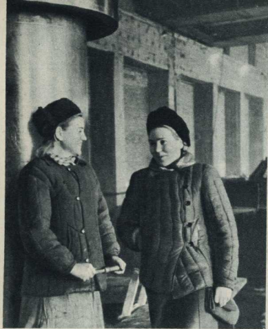
На монтажной площадке строительства (слева направо): слесарь-сборщик Александра Юлмакова и молодой инженер Валерия Филиппова.
