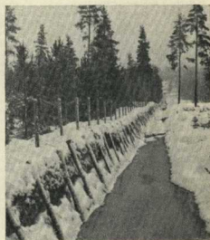
... губоками противотанковыми ярами укреплен- ные бетоном.
