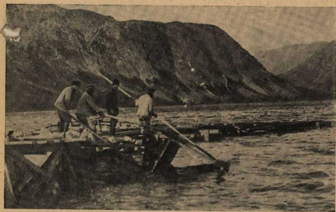
Началась стройка электростанции на озере Большой Вудъяр.
