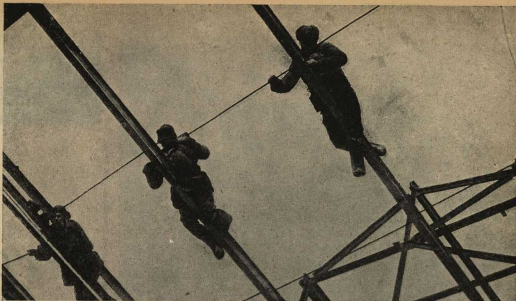
Строится механоборочный цех нижегородского автогиганта.
