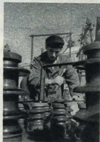
Электрослесарь Анатолий Антонов внимательно следит за исправностью оборудования шахты.
