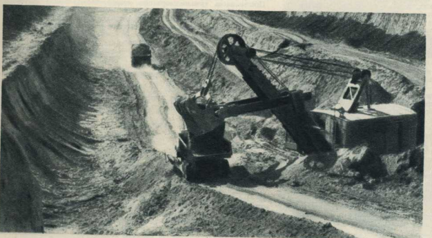
Сталинградгидрострой. Здесь соорудится самотечный канал Волга — Ахтуба.
