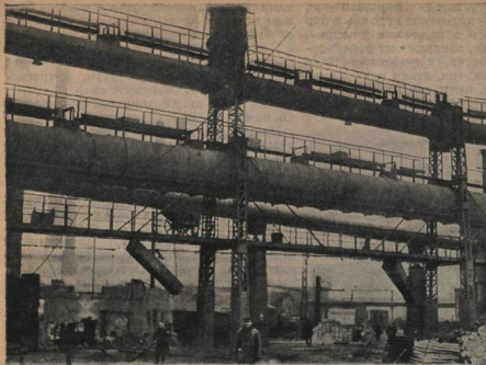
Трубопроводы от газоочистительной Днепропетровского комбината им. Дзержинского
