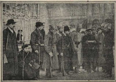
Проверка пропусков при входе в Смольный
