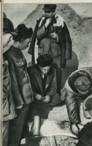
Советский инженер Бувов вместе с китайским инженером на берегу реки Хуайцзи решают вопрос об отводных каналах Мияоцао.
