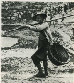
За короткое время работ на Хуайцзи вырыто в 2 раза больше земли, чем на строительстве Суэцкого канала.
