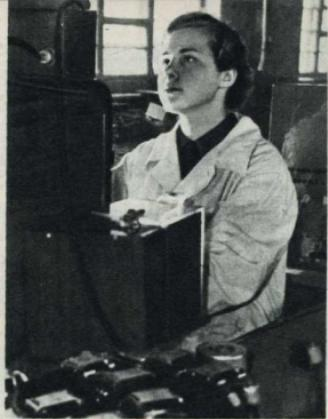
Тамара Рубцова внимательно следит за приборами. Она проверяет на специальной установке качество токопроводов в стручных трансформаторах.
