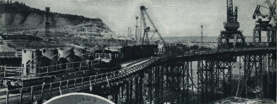
Девять порталных кранов действуют на бетонозаводской эстакаде, подавая в котлован арматуру, опалубку, бадьи с бетоном. Справа внизу — котлован водосливной плотины будущей гидроэлектростанции.
