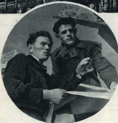
Среди молодых гидростроителей пользуются заслуженной славой старший инженер-электрик Алексей Прокудин (слева) и главный инженер 2-го строительного участка Юрий Остапченко.
