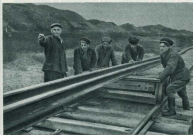
Так укладывает рельсы бригада В. Рындина.
