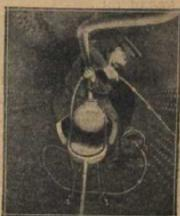
Автоматическая сварка при помощи кислорода
