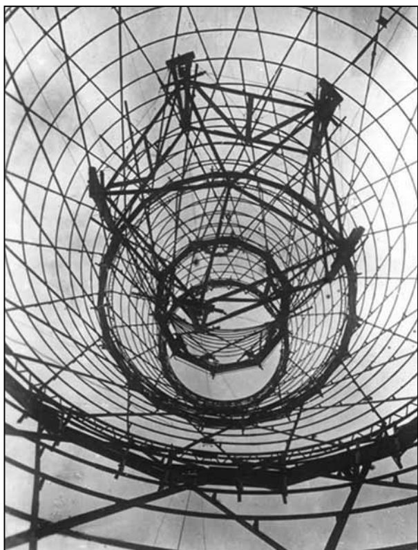
Радиомачта системы В.Г. Шухова в Москве (Шуховская башня)
