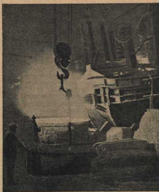
Плавильная печь, в которой доменная пыль и железные опилки, смешиваясь, образуют глыбы металла
