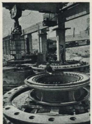
Подготовка деталей турбин к монтажу.
