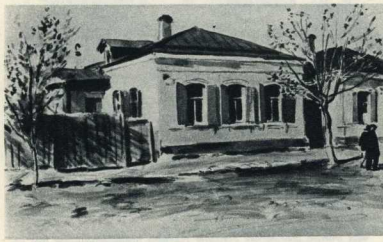
В 1875 году семья Чеховых переехала на Контorskую улицу (ныне улицы Розы Люксембург).
