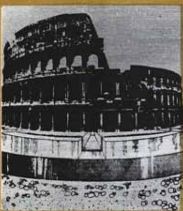
Долговечность древнего сооружения пережившего землетрясения, войны и прочие катаклизмы, обеспечена именно наличием этого эллипсовидного кольца, на которое опираются несущие колонны и соединительные элементы. Под самим же фундаментом находится не туф, как считали до последнего времени, а компактные сплошные отложения озерного и морского происхождения, то есть разные виды пластичной глины.
