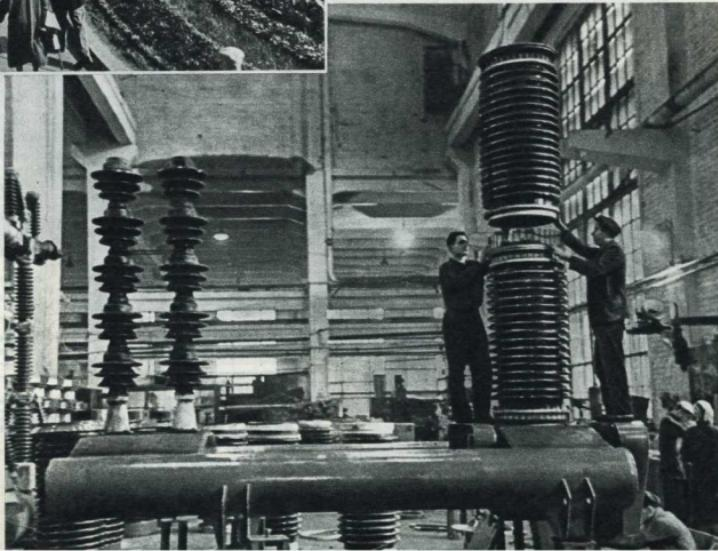
Ленинградский завод «Электроаппарат». Сборка воздушного выключателя на 220 тысяч сиc вольт.
