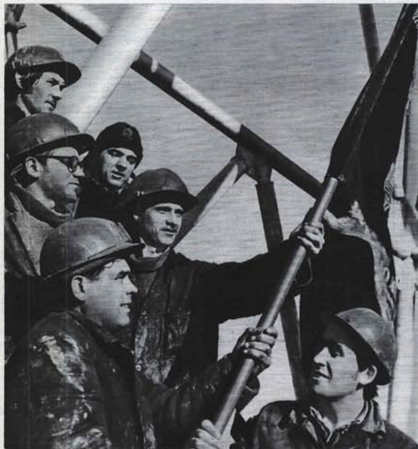
МОНТАЖНИКИ. Фото Николая КЛАДИТИ (Жданов).
