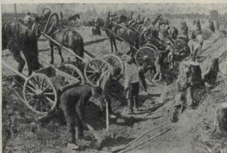
ЗДЕСЬ БУДЕТ ПОСТРОЕН НОВЫЙ ЗАВОД. На фото: работы по очистке места под постройку машиностроительного гиганта на Урале.
