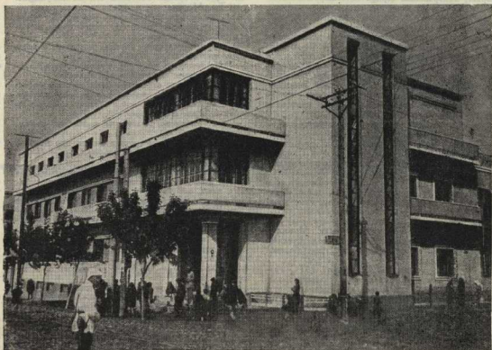
Для строительных рабочих воздвигнут великозальный клуб.
