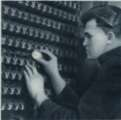
Леонид Теплов, электромеханик метро, за регулировкой реле.
